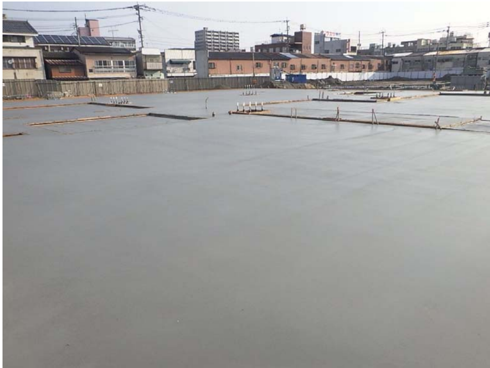
撮影内容 4 2工区 土間スラブコンクリート打設完了
