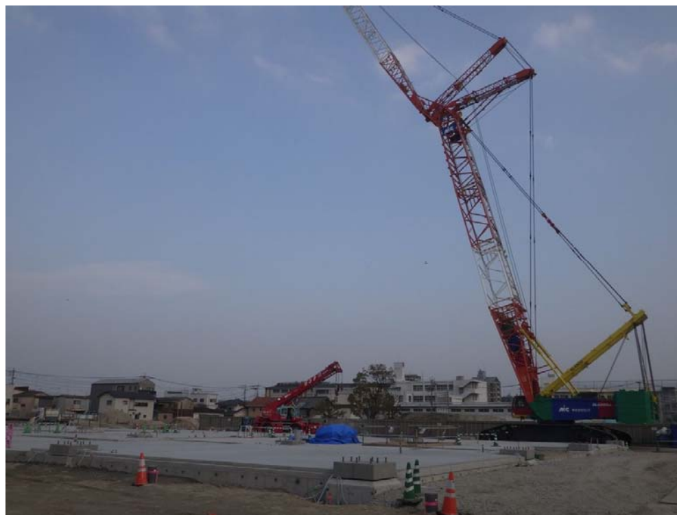
撮影内容 6 健診センター 全景写真(北西面より) 3月31日現在
