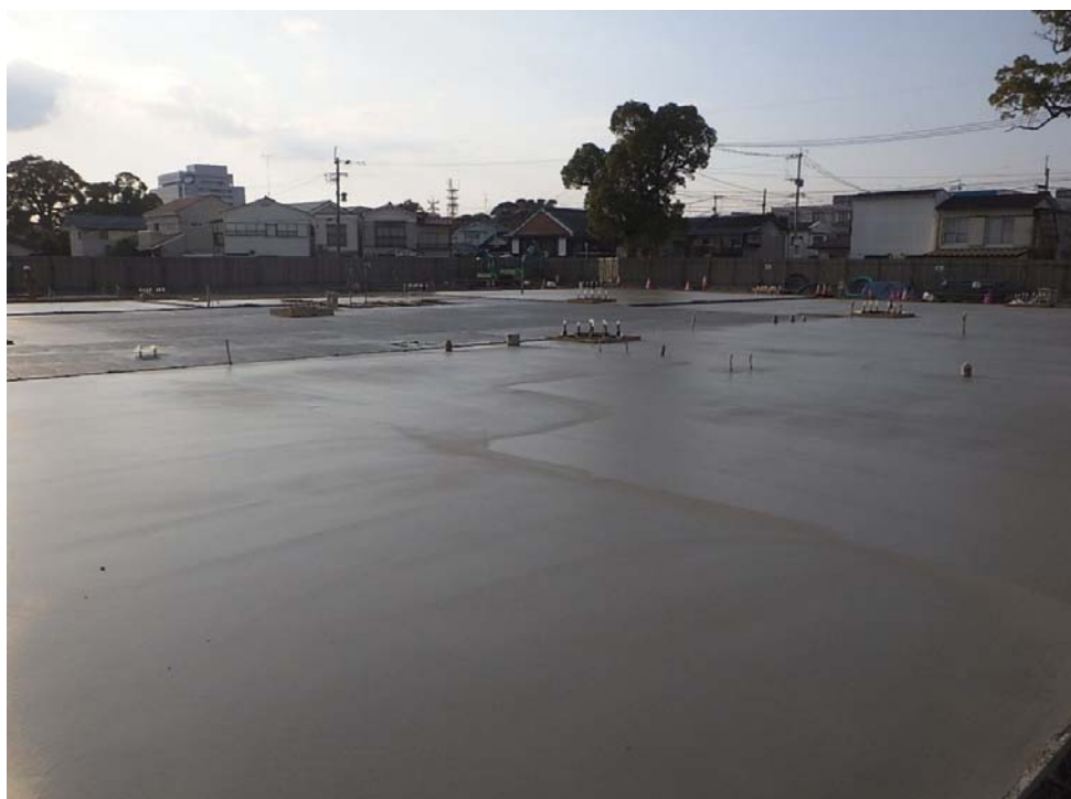
撮影内容 2 1工区 土間スラブコンクリート打設完了
