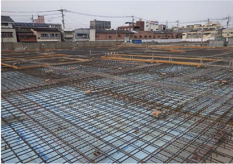
撮影内容 3 2工区 土間スラブ配筋完了
