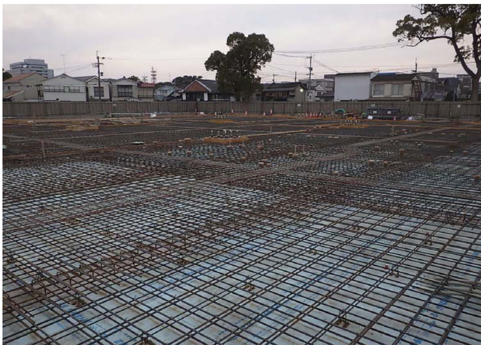
撮影内容 1 1工区 土間スラブ配筋完了
