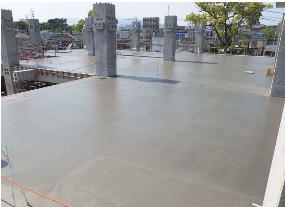
撮影内容 4 1工区 2Fスラブコンクリート打設完了
