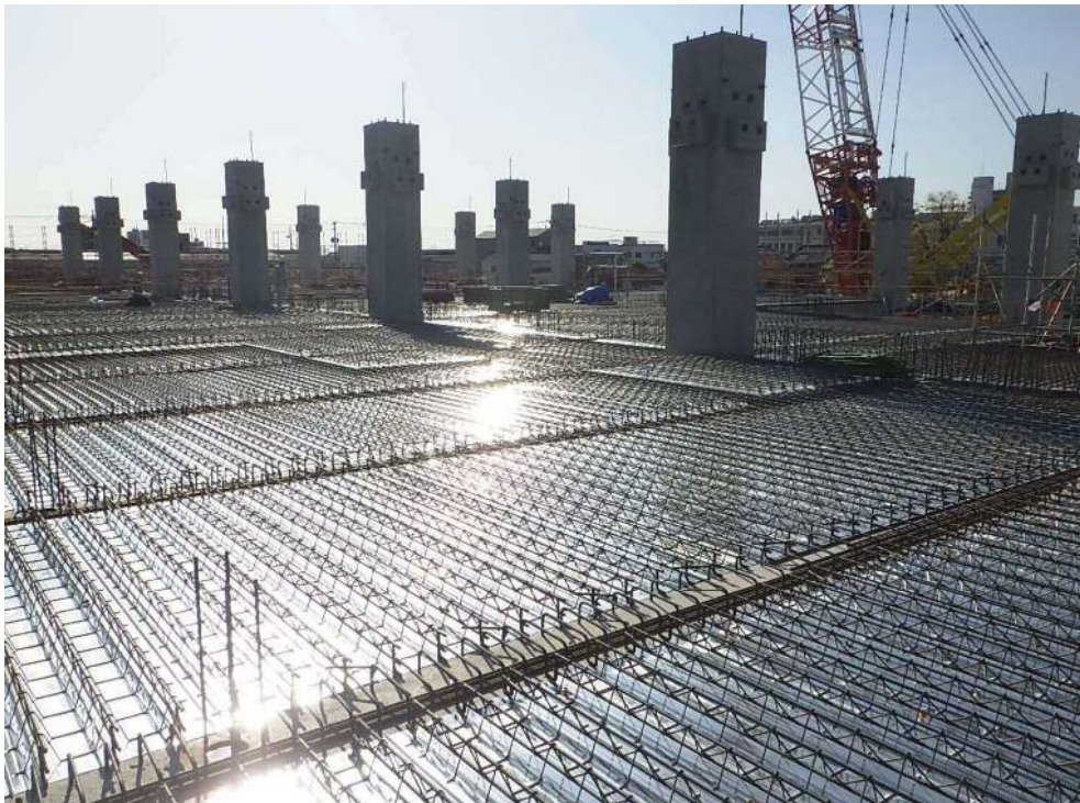
撮影内容 2 1工区 2Fデッキ張り完了
