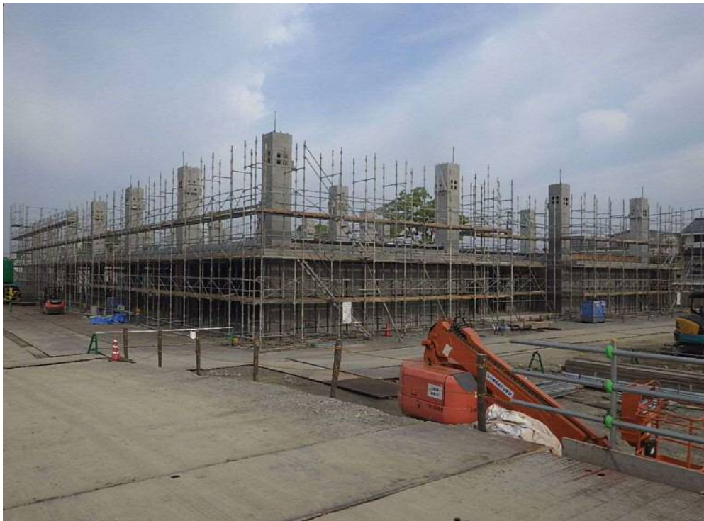
撮影内容 8 全景写真(南東面より) 4月29日現在
