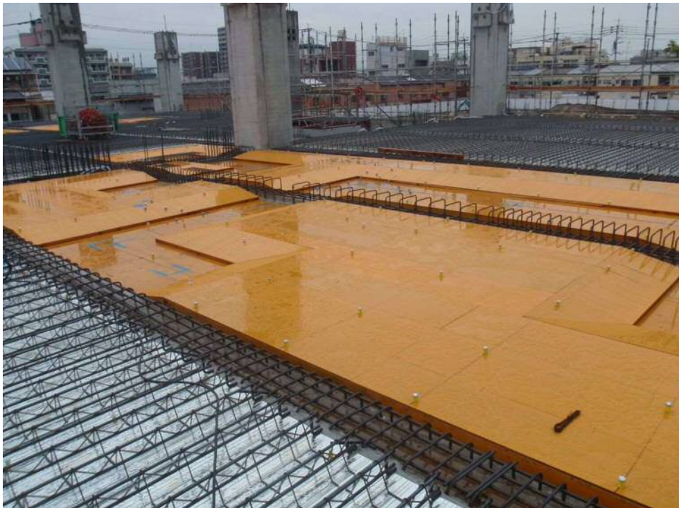
撮影内容 6 2工区 2Fデッキ・在来スラブ張り完了
