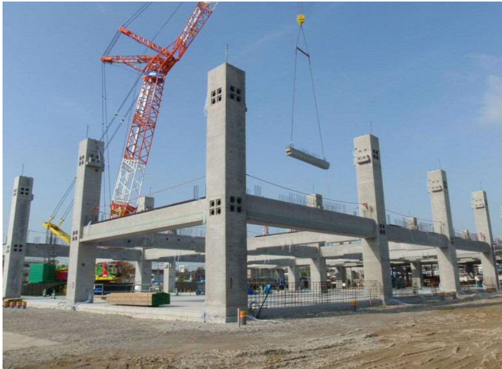
撮影内容 5 2工区 2F梁架設状況
