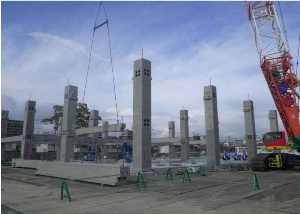
撮影内容 1 1工区 2F PC梁架設状況
