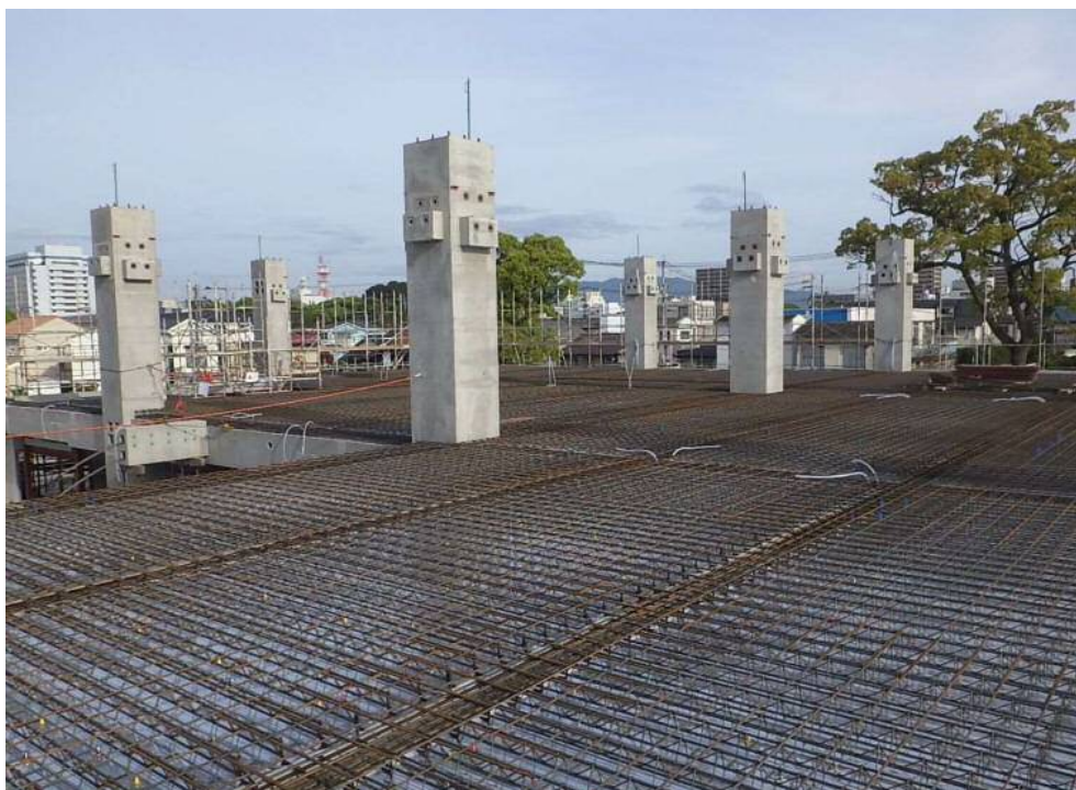
撮影内容 3 1工区 2Fスラブ配筋完了
