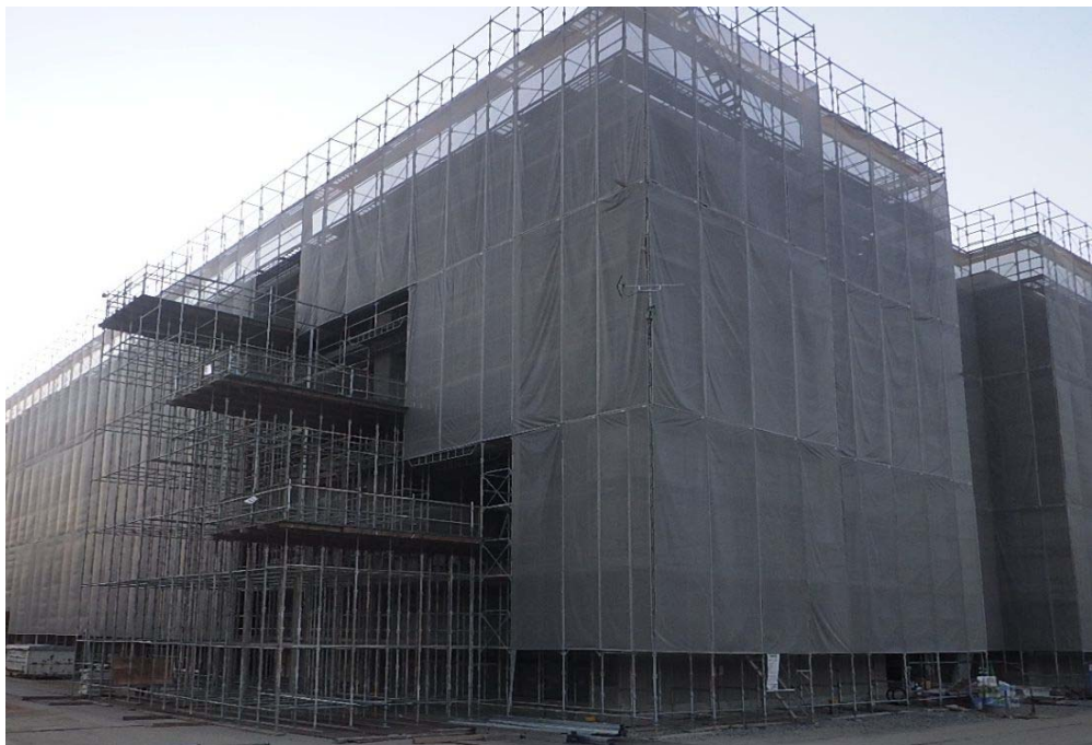
撮影内容 10 健診センター 全景写真(南東面より) 8月31日現在
