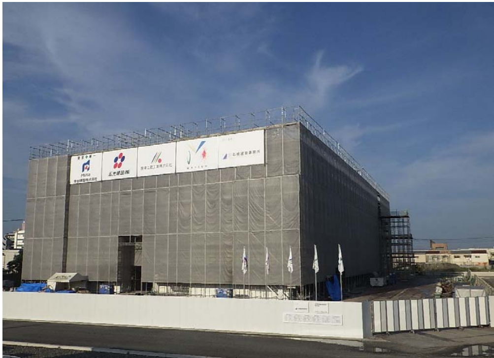
撮影内容 9 健診センター 全景写真(南東面より) 8月31日現在
