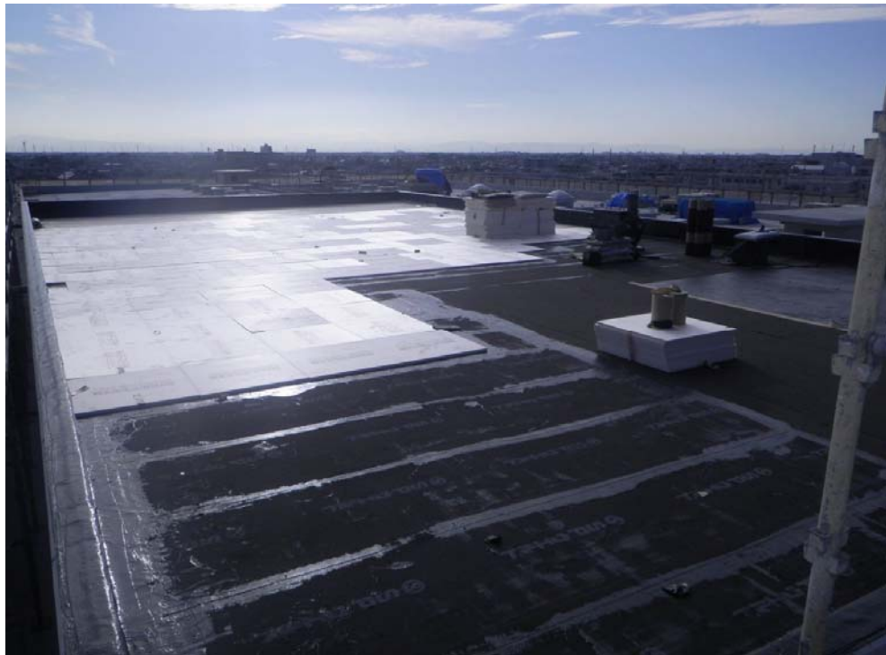
撮影内容 2 R2F アスファルト防水状況
