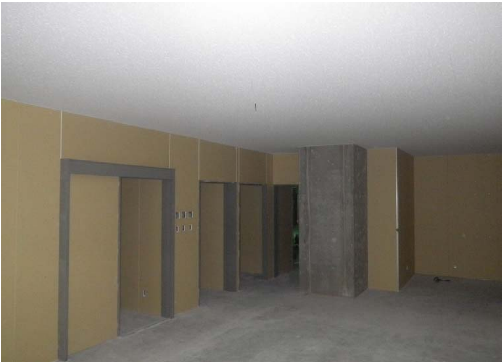
撮影内容 4 2F 天井ボード張り状況
