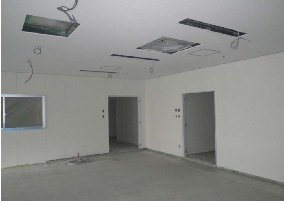
撮影内容 3 1F 壁塗装状況
