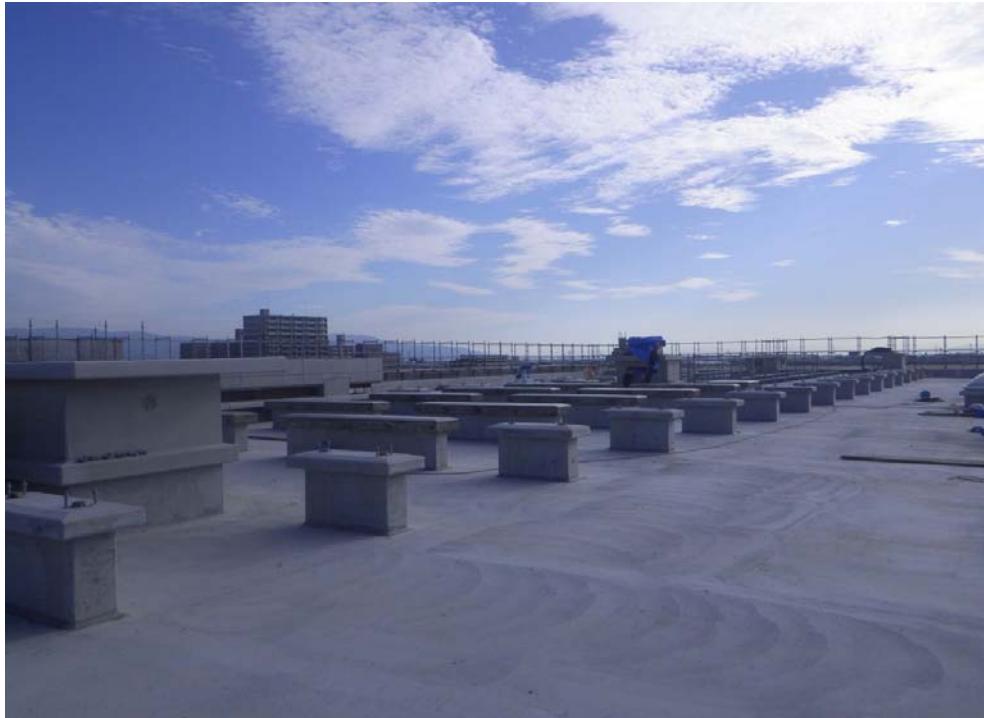
撮影内容 1 RF・R2F パラペット・機械基礎CON完了
