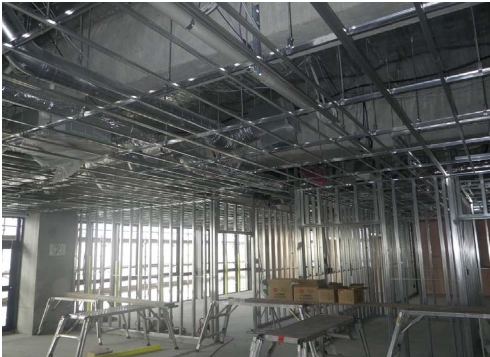
撮影内容 5 3F 天井・壁軽鉄下地組状況
