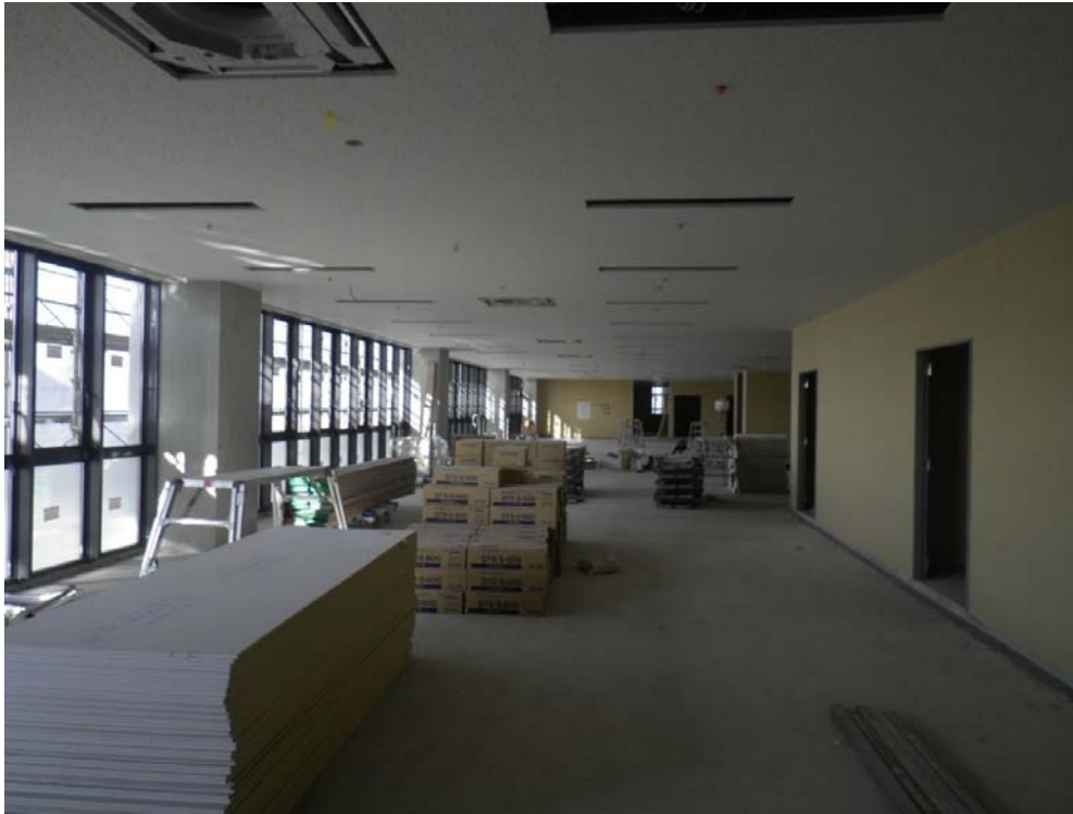
撮影内容 5 3F 天井ボード張り状況
