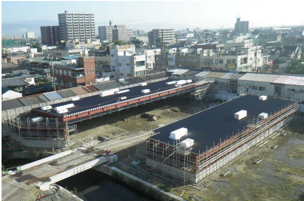
撮影内容 8 バス車庫1・2 屋根葺き完了
