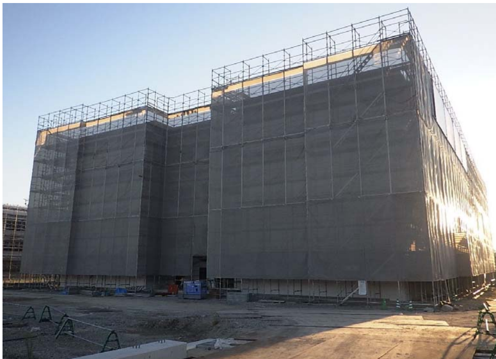
撮影内容 10 健診センター 全景写真(北東面より) 9月30日現在
