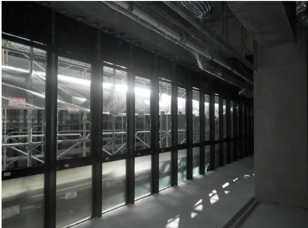
撮影内容 6 4F 内部アルミサッシ取付完了
