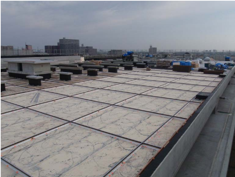
撮影内容 1 RF アスファルト防水、伸縮目地張り状況
