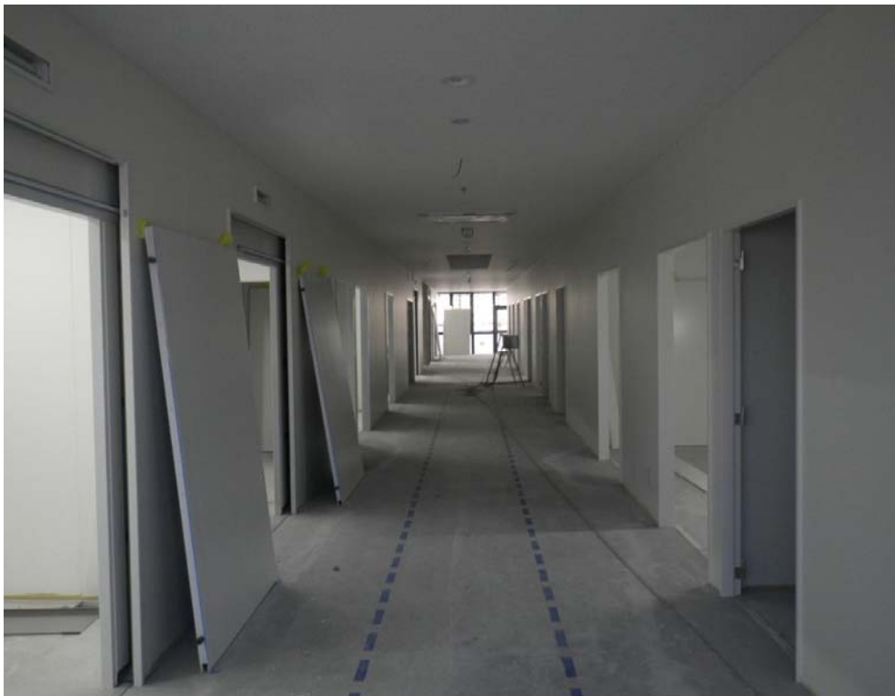
撮影内容 4 2F 壁塗装状況
