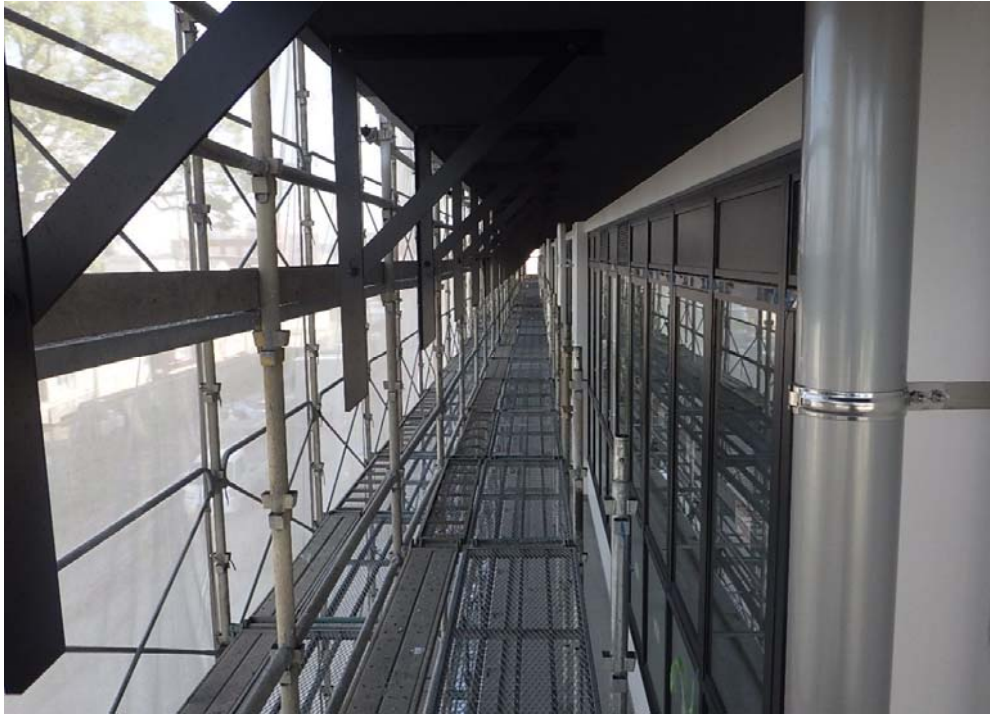
撮影内容 7 3・4F 外壁塗装・ルーバー下地取付状況
