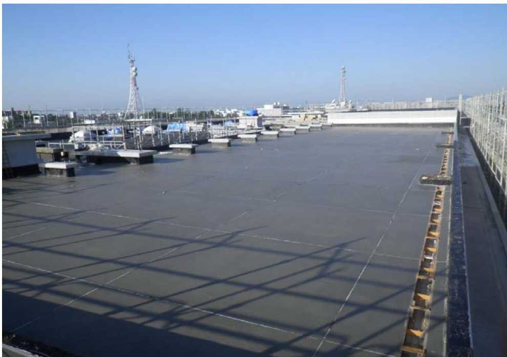
撮影内容 2 RF 防水保護コンクリート打設完了
