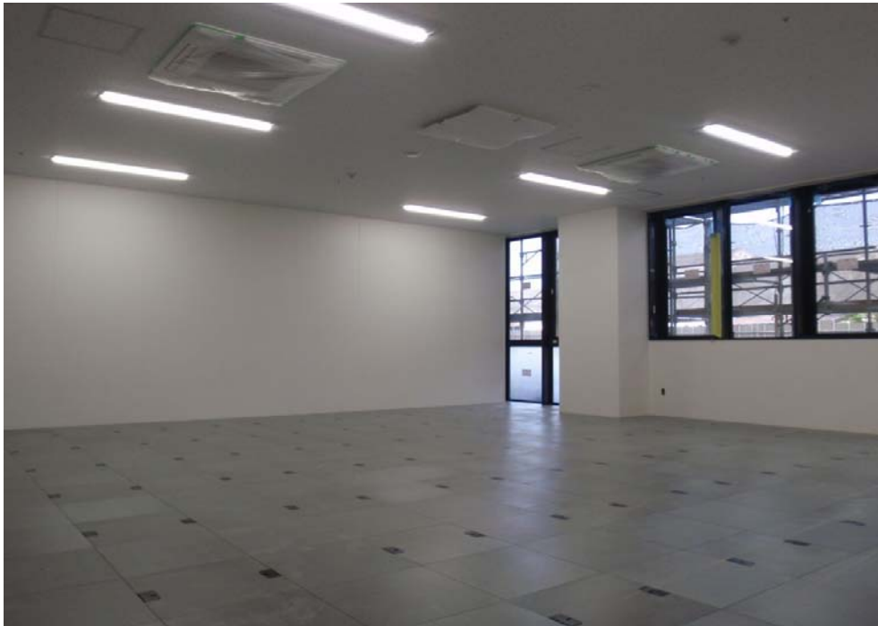
撮影内容 3 1F 床工事(OAフロア)施工状況
