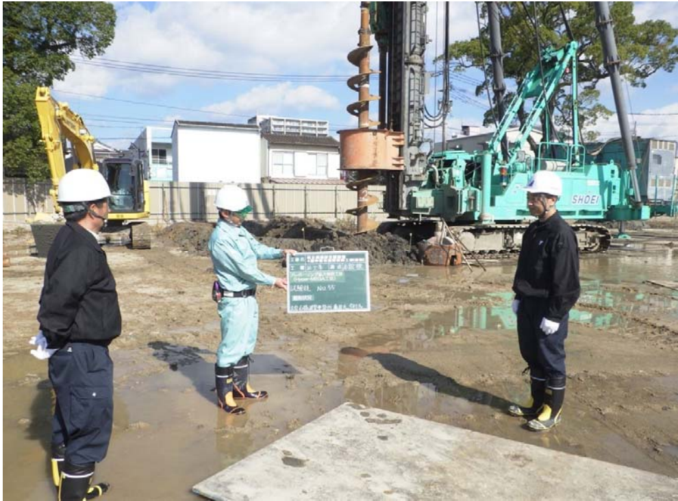
撮影内容 3 試験杭施工状況 11月11日現在
