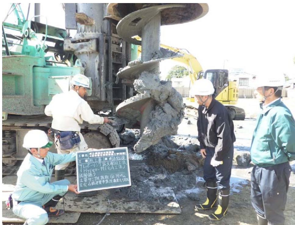
撮影内容 2 試験掘り状況 11月9日撮影
