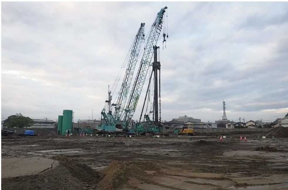
撮影内容 6 全景写真 11月30日現在
