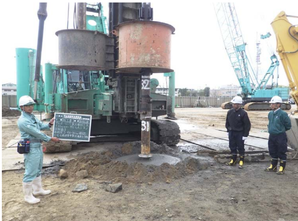
撮影内容 1 試験掘り状況 11月9日撮影
