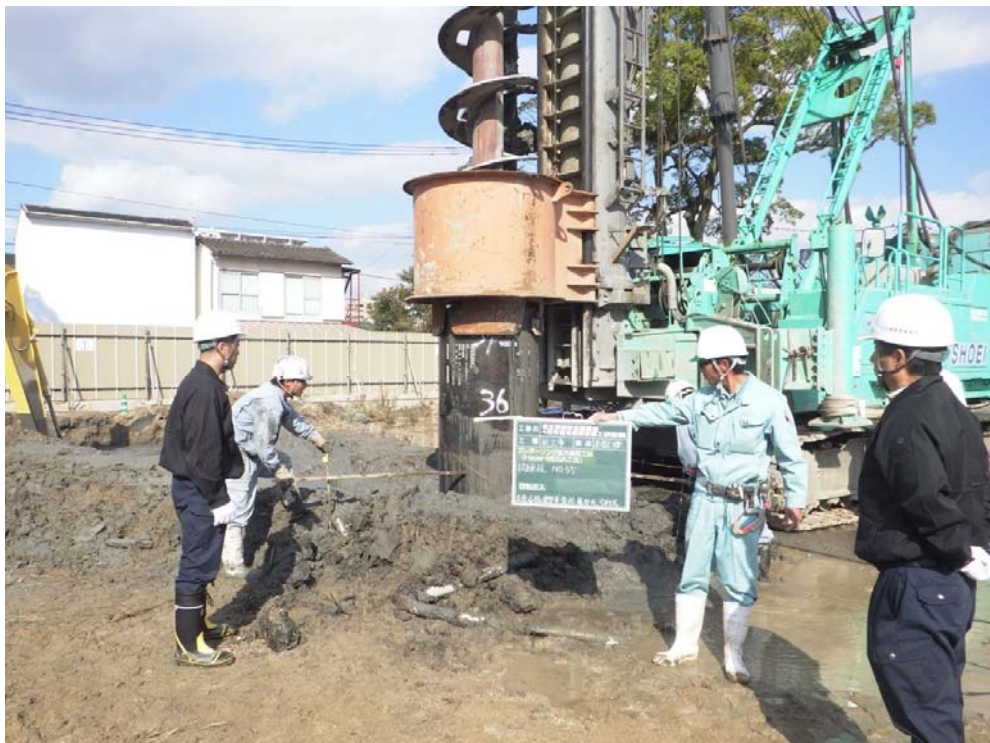
撮影内容 4 試験杭施工状況 11月11日現在
