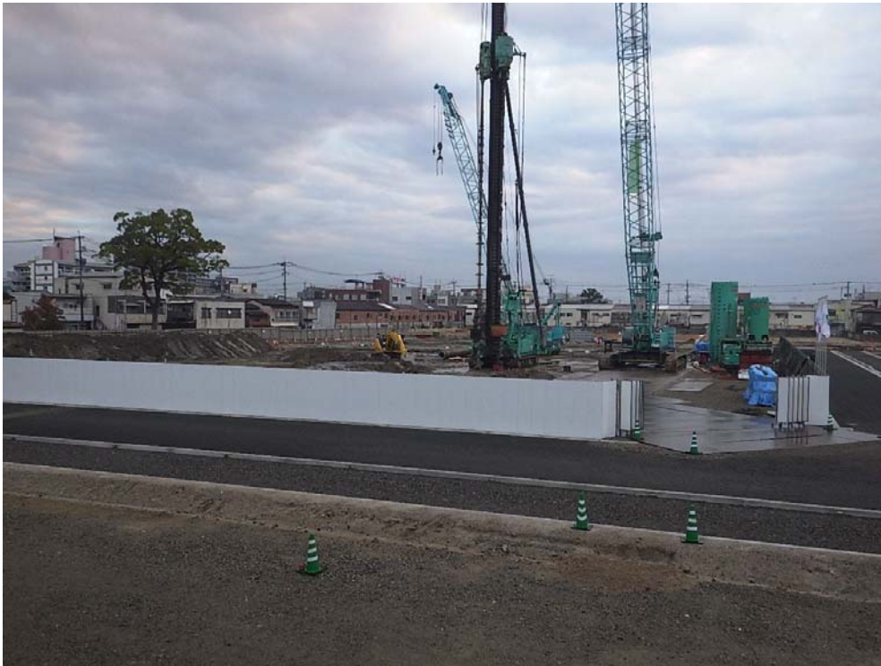
撮影内容 5 全景写真 11月30日現在
