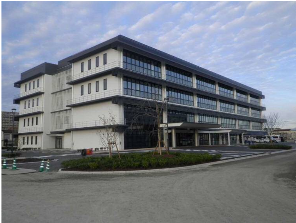
撮影内容 9 健診センター 全景写真(南西面より) 11月30日現在
