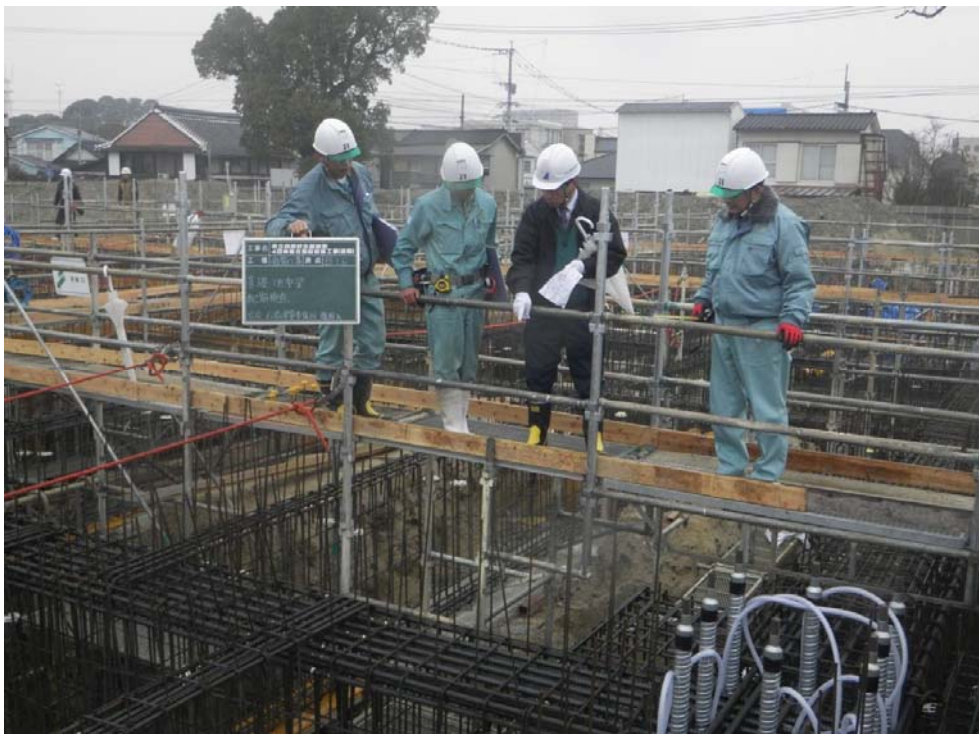
撮影内容 6 B工区 基礎・地中梁配筋検査状況
