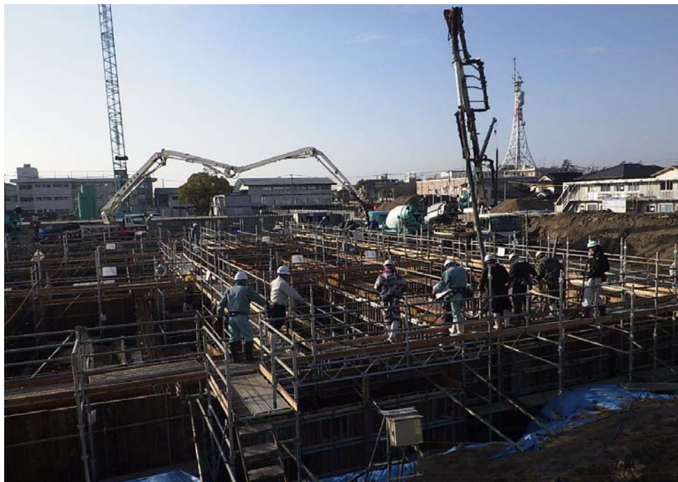
撮影内容 4 A工区 基礎・地中梁CON打設状況
