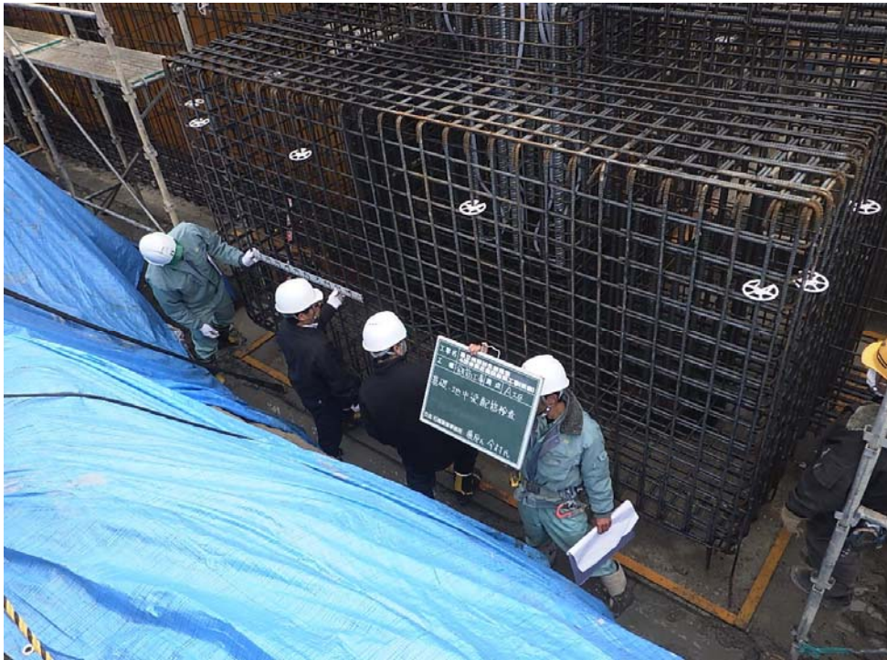
撮影内容 1 A工区 基礎・地中梁配筋検査状況
