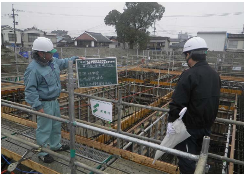
撮影内容 2 A工区 基礎・地中梁CON打設前検査状況
