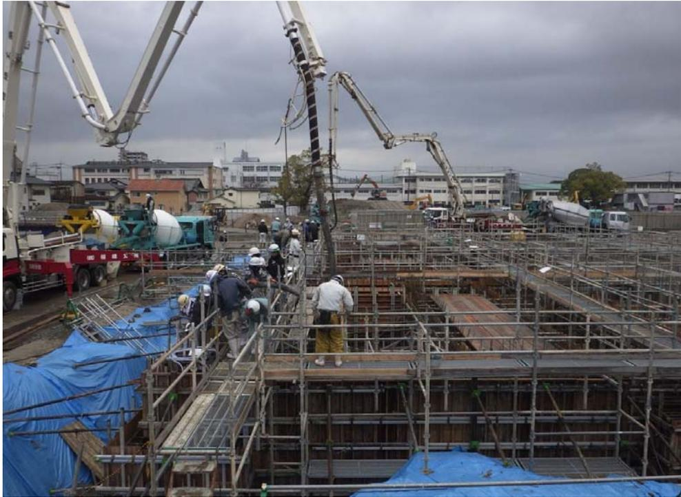
撮影内容 5 D工区 基礎・地中梁CON打設状況
