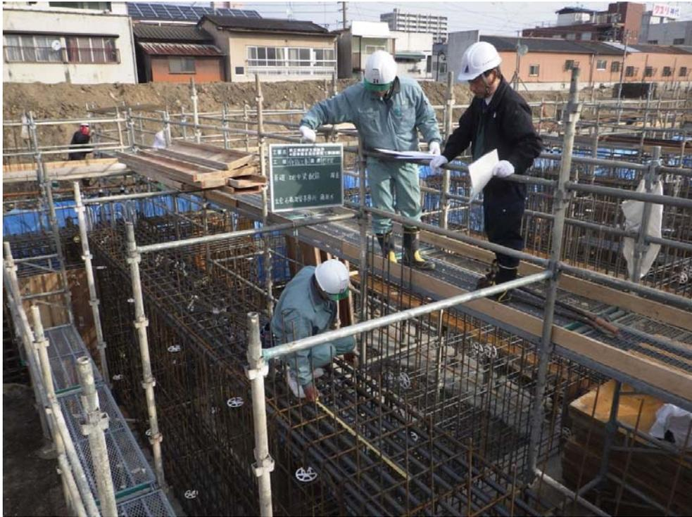
撮影内容 3 C工区 基礎・地中梁配筋検査
