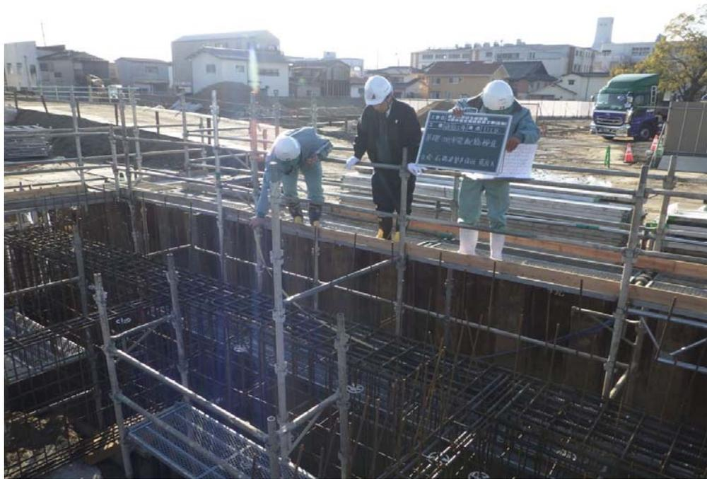
撮影内容 4 D工区 基礎・地中梁配筋検査
