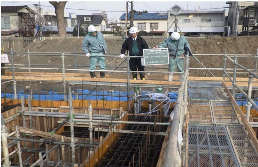
撮影内容 2 B工区 基礎・地中梁CON打設前検査状況
