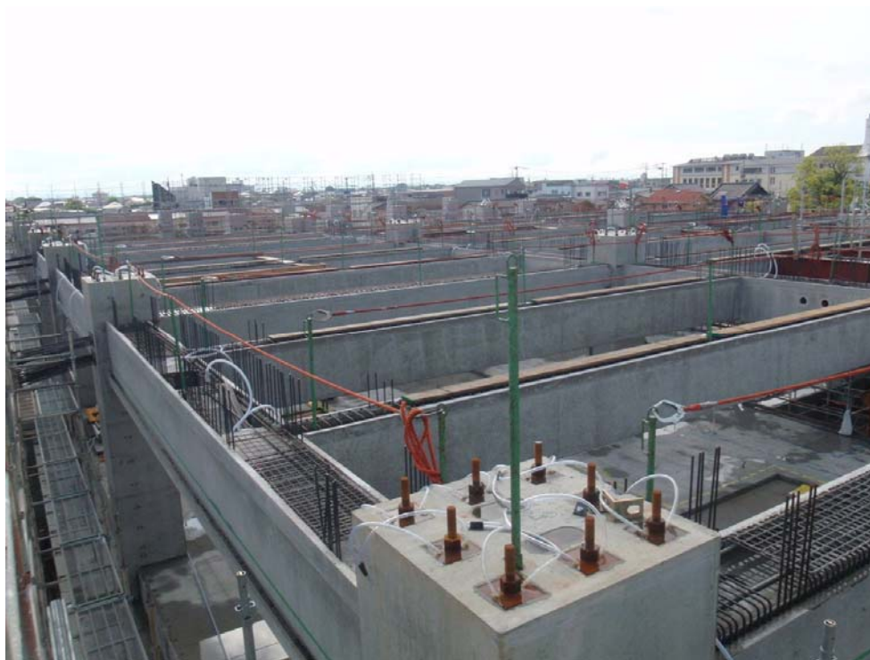
撮影内容 2 1工区 3F梁架設完了
