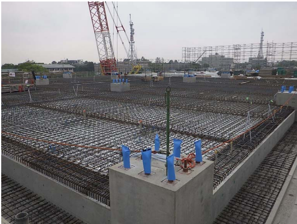
撮影内容 6 2工区 3Fスラブ配筋完了
