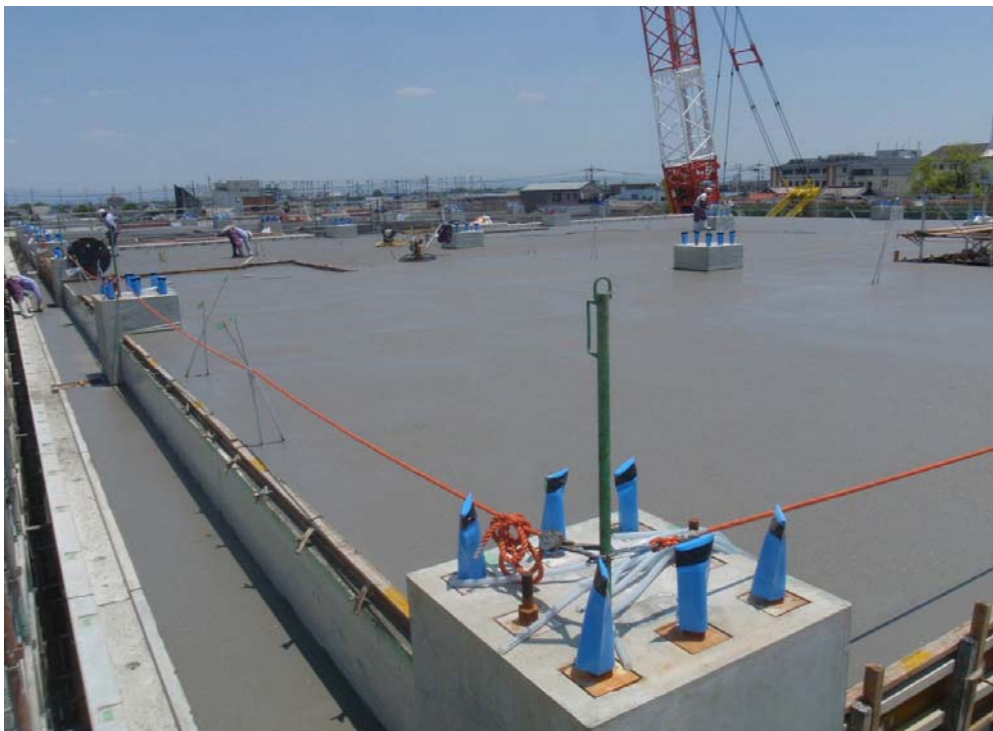
撮影内容 4 1工区 3Fスラブコンクリート打設状況
