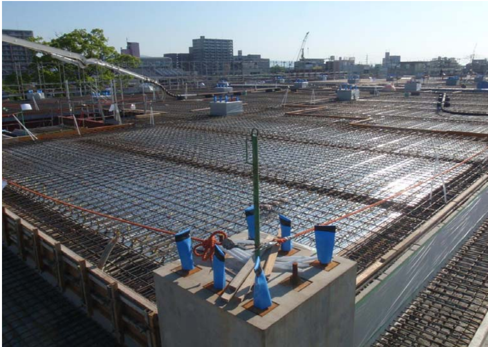
撮影内容 3 1工区 3Fスラブ配筋完了
