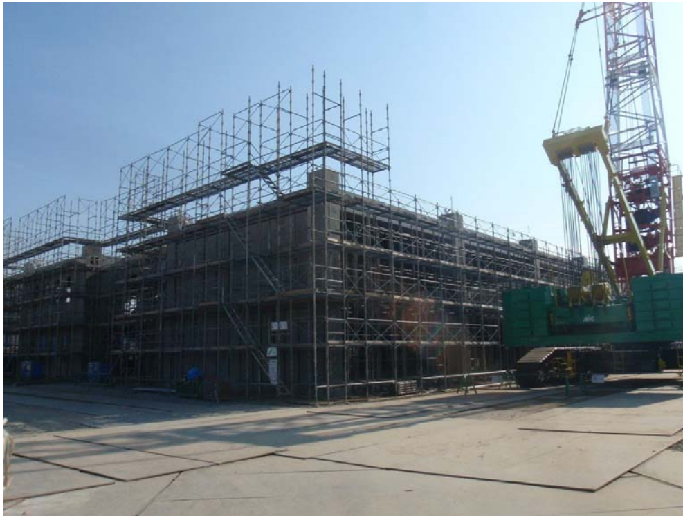
撮影内容 7 健診センター 全景写真(南西面より) 5月29日現在
