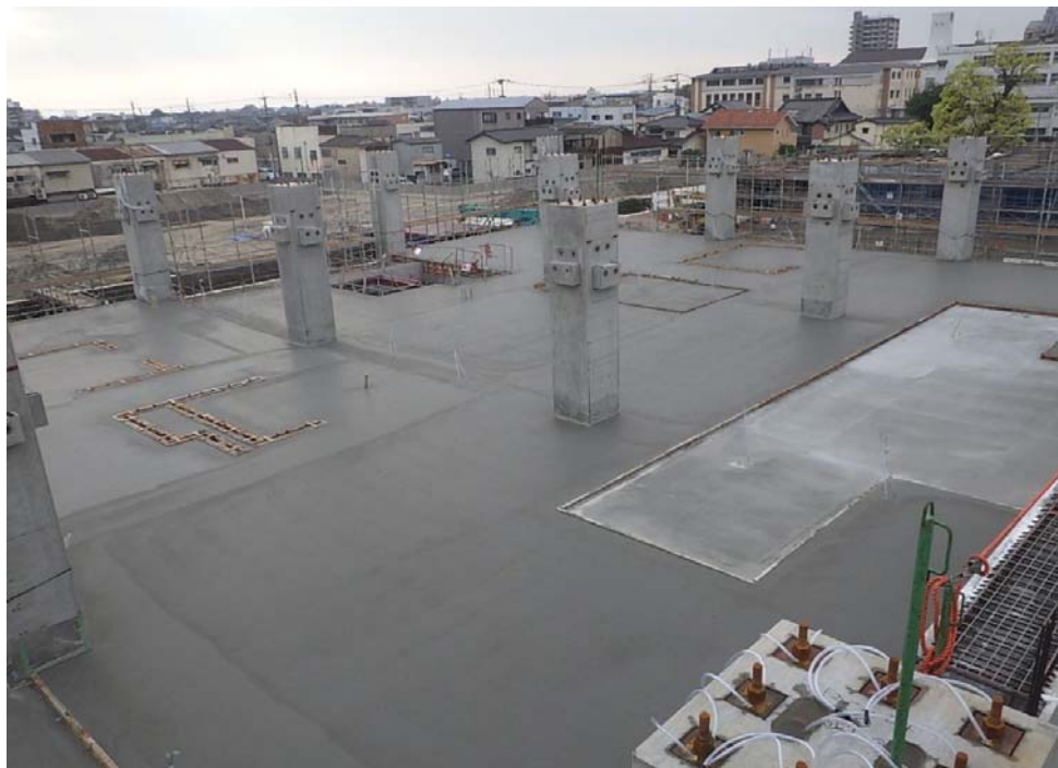
撮影内容 1 2工区 2Fスラブコンクリート打設完了
