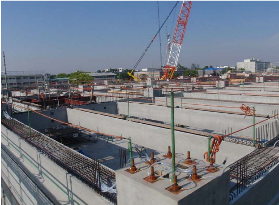
撮影内容 5 2工区 3F梁架設完了
