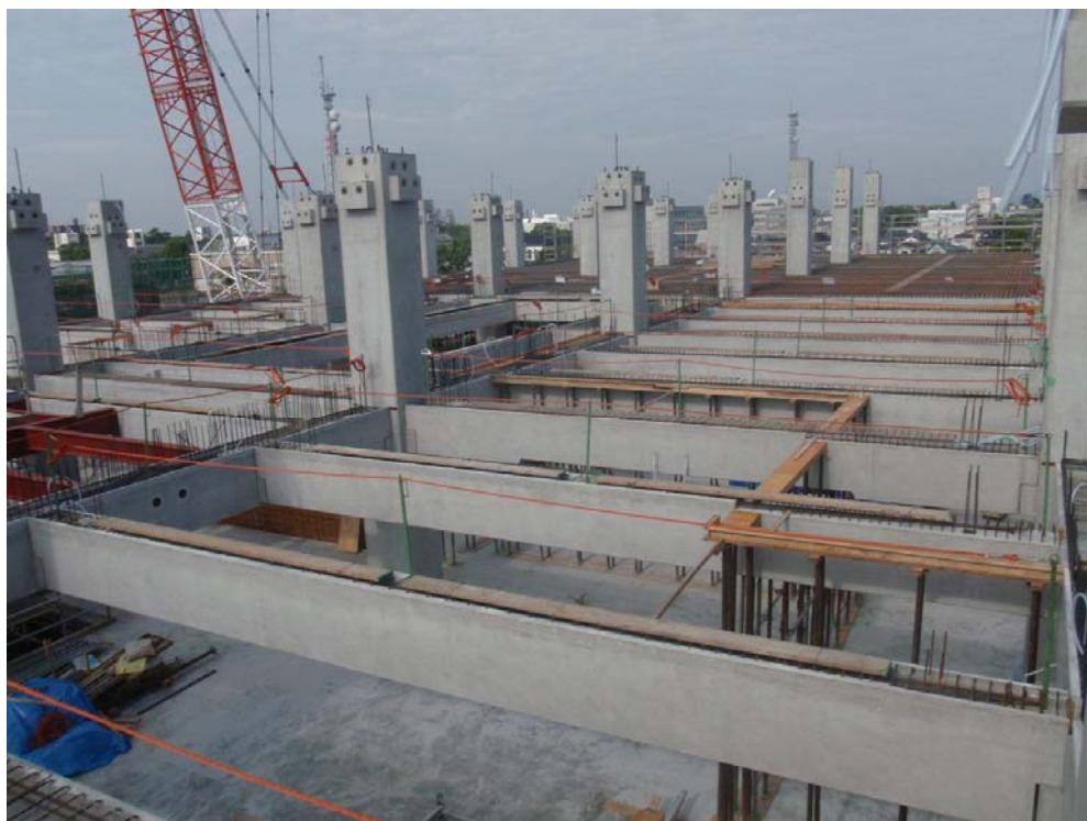
撮影内容 5 2工区 4F PC梁架設完了
