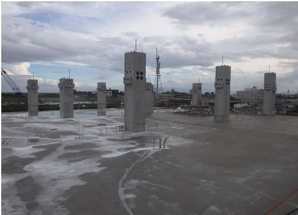
撮影内容 4 1工区 4Fスラブコンクリート打設完了
