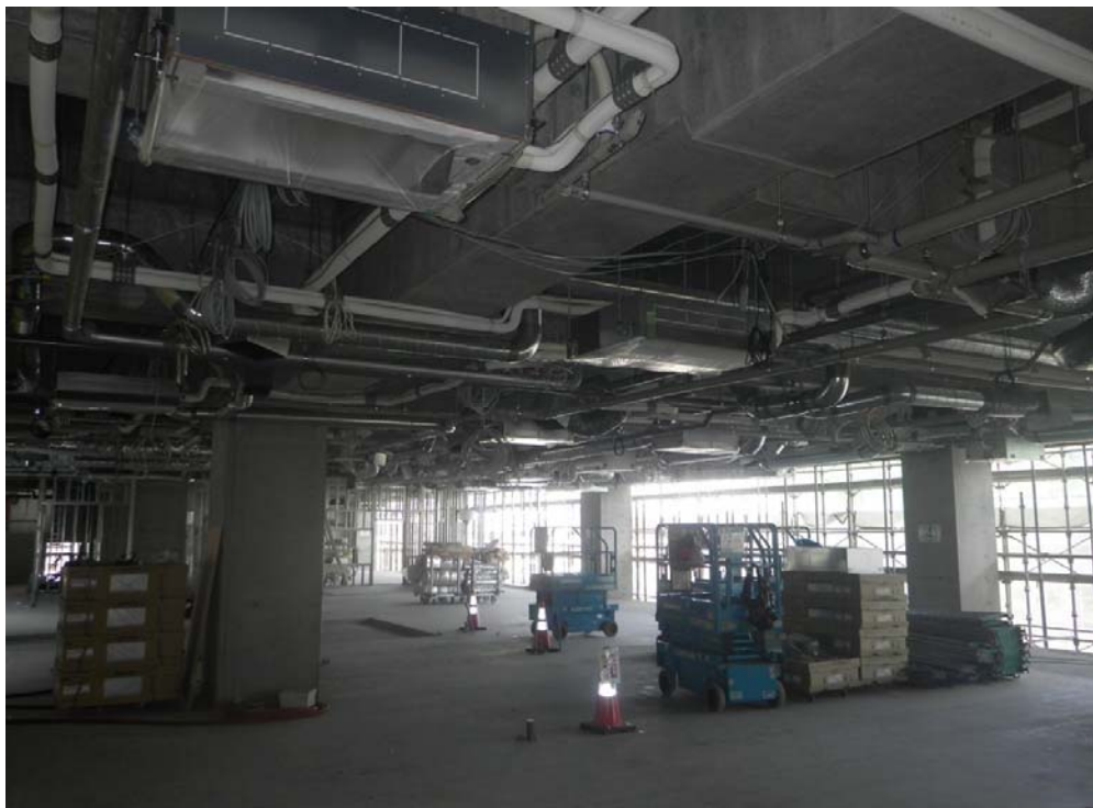
撮影内容 8 2F 天井内配管・機器取付状況
