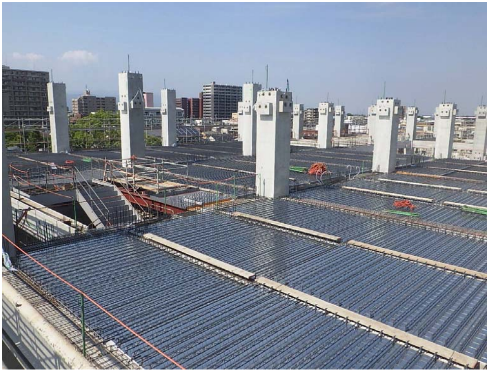
撮影内容 3 1工区 4Fデッキ張り完了
