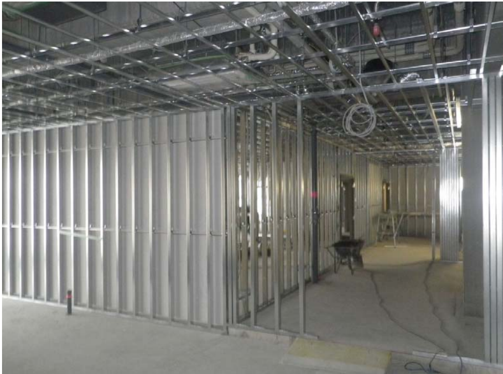
撮影内容 7 1F 壁・天井軽鉄下地組状況
