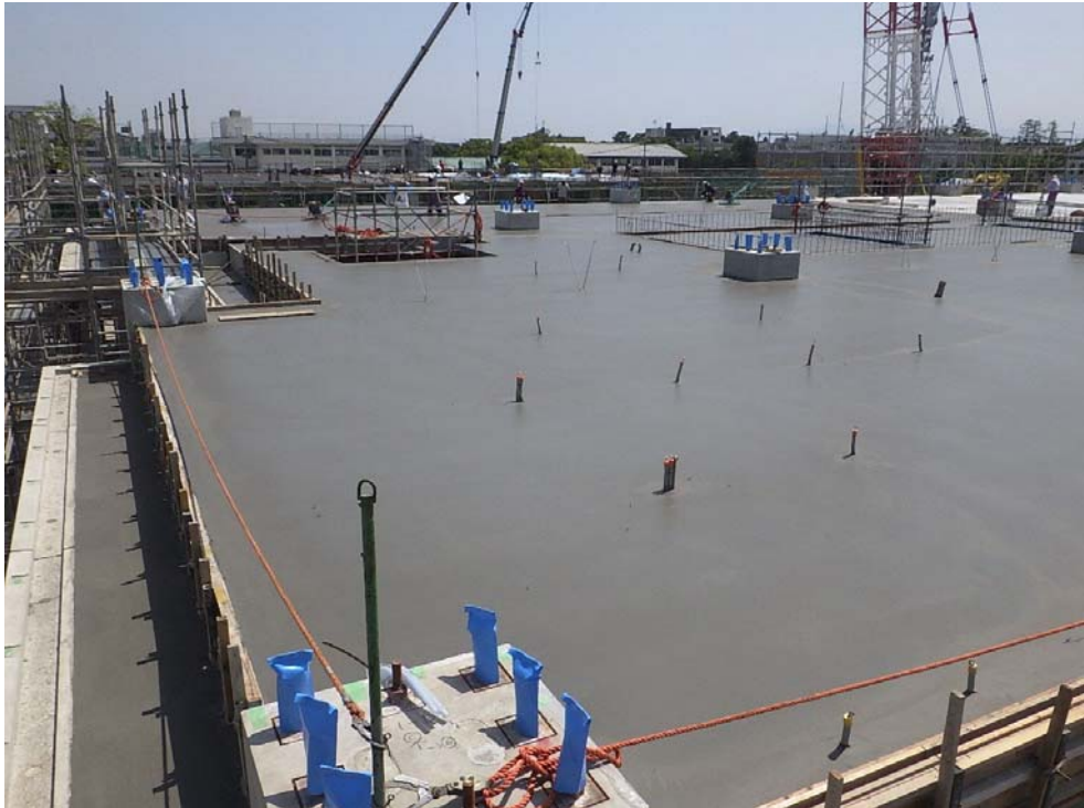
撮影内容 1 2工区 3Fスラブコンクリート打設完了
