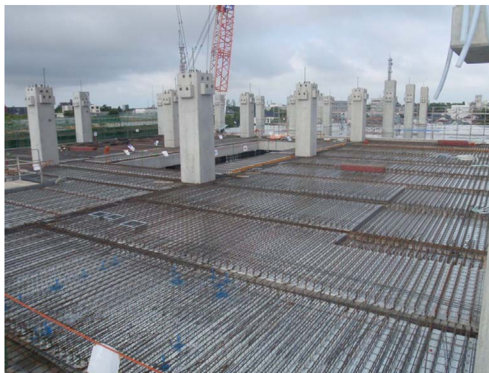
撮影内容 6 2工区 4Fスラブ配筋状況
