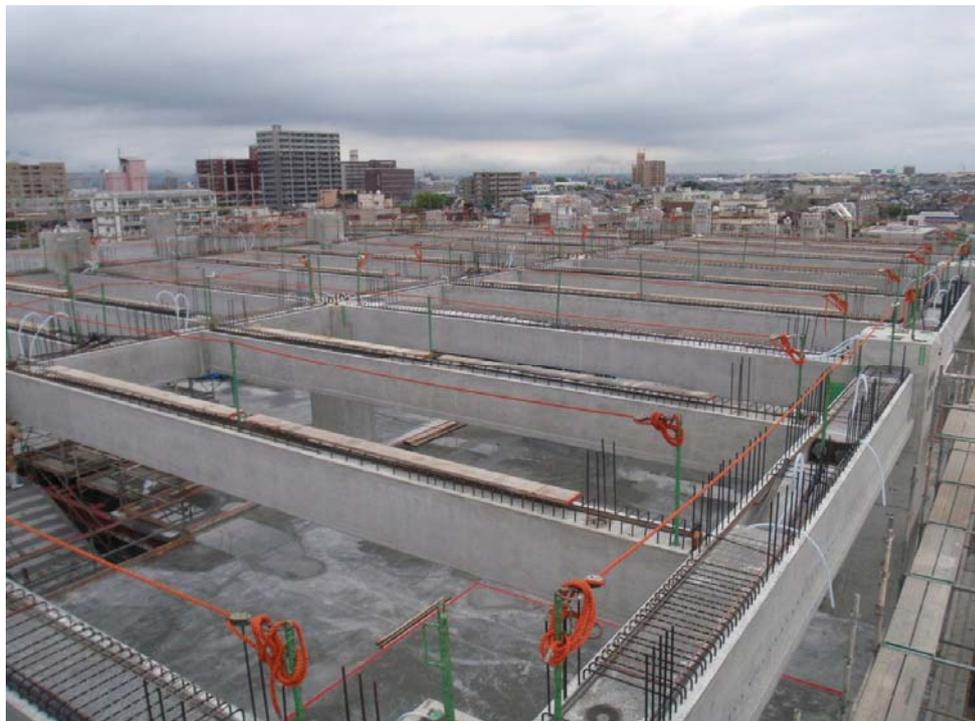
撮影内容 3 1工区 RF PC梁架設完了
