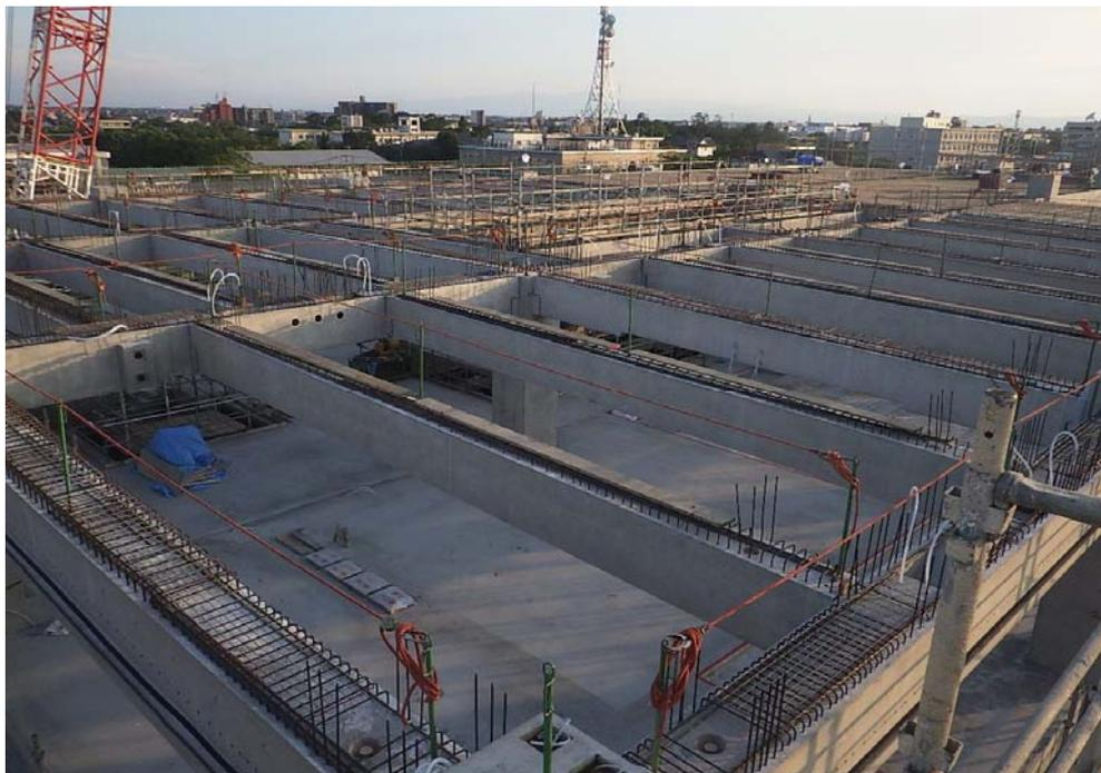
撮影内容 6 2工区 RF PC梁架設完了
