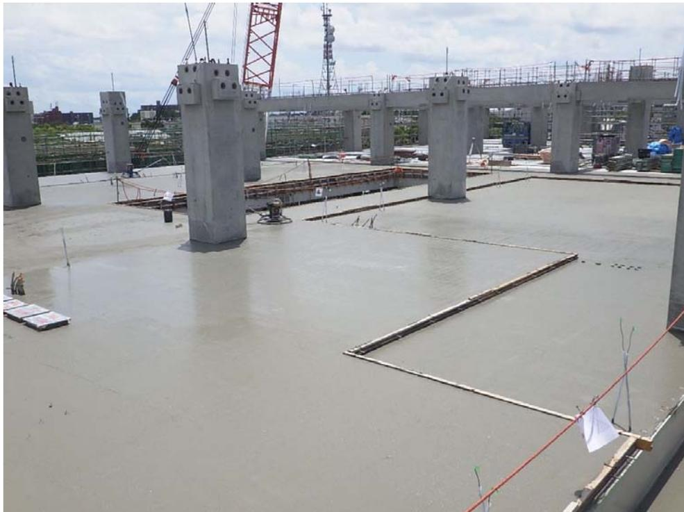
撮影内容 2 2工区 4Fスラブコンクリート打設完了
