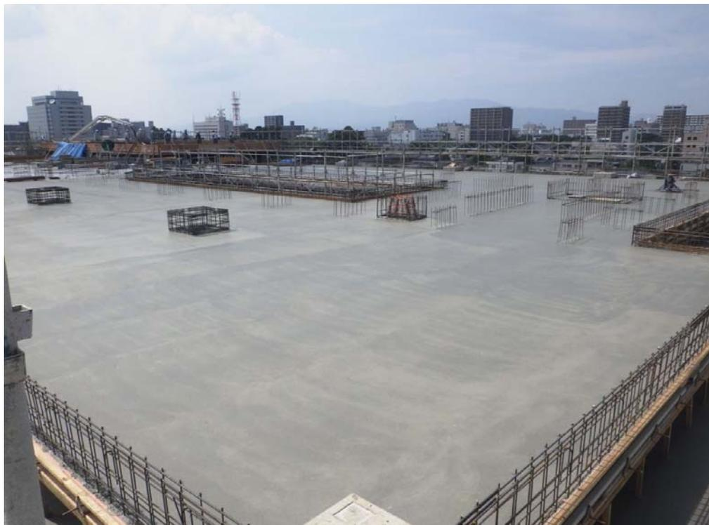
撮影内容 8 2工区 RFスラブコンクリート打設完了(上棟)
