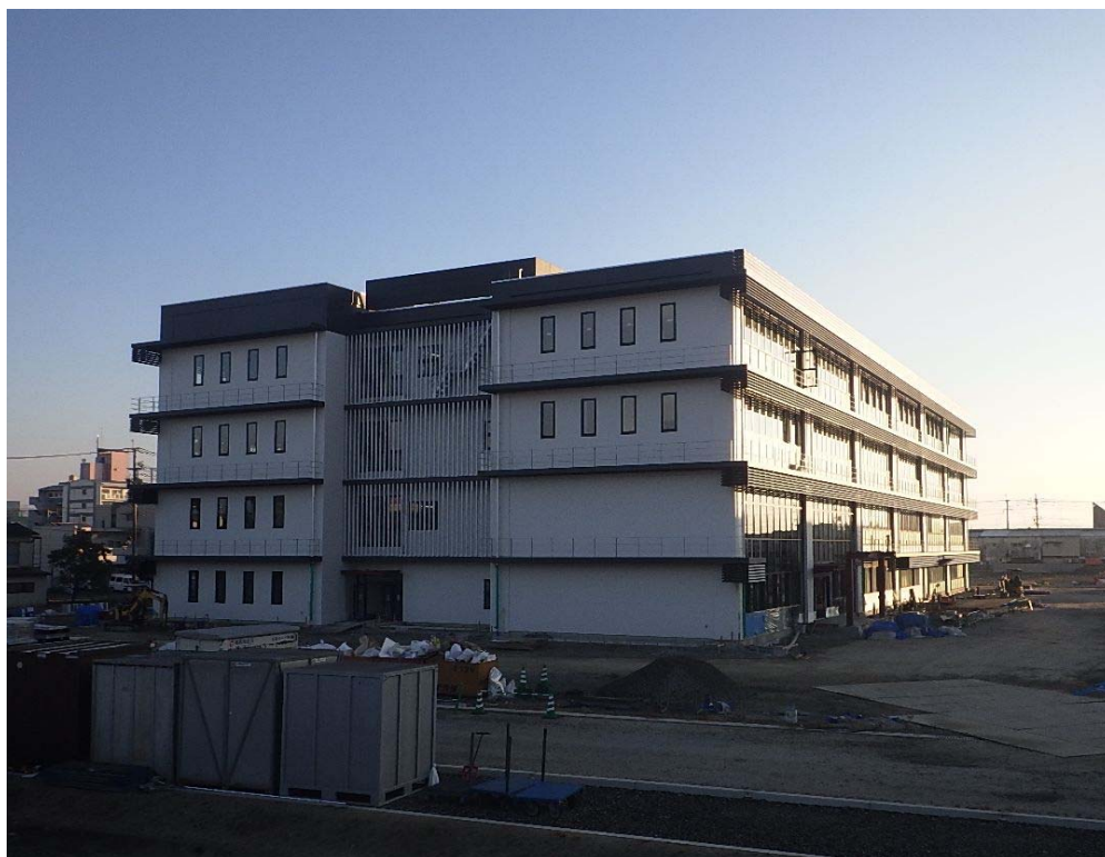
撮影内容 7 健診センター 全景写真(南西面より) 10月31日現在
