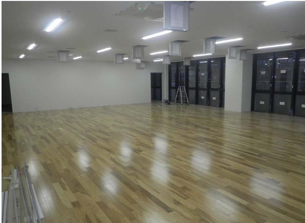
撮影内容 2 1F 床工事(フローリング貼り)施工状況
