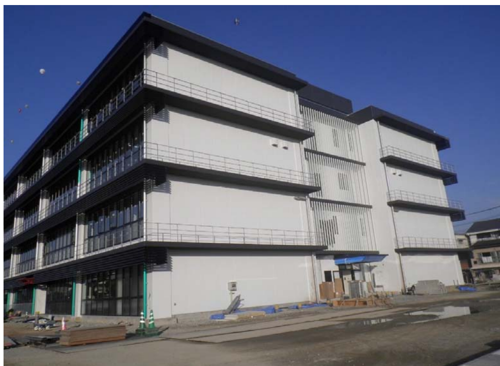
撮影内容 8 健診センター 全景写真(南東面より) 10月31日現在
