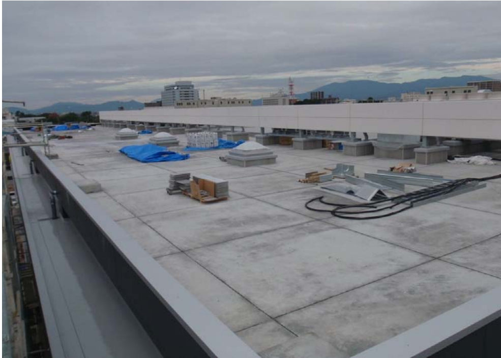
撮影内容 1 RF 目隠しパネル取付完了
